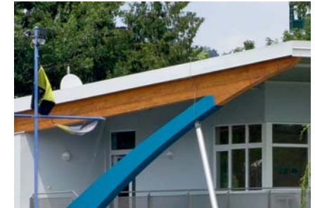
Auskragungsdetail (Holz, Stahl, Beton)
