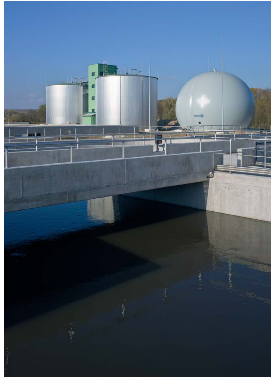
Faultürme, Gasspeicher
