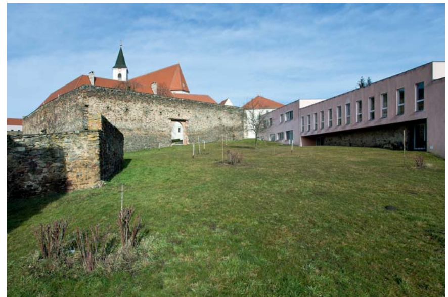
Neubau, Mauerbereich Innenhof
