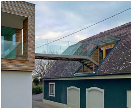
Brückenverbindung Alt- zu Neubau
