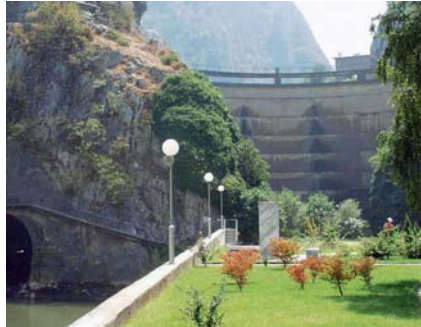
Kraftwerk bei Matka (Nr. 1)
