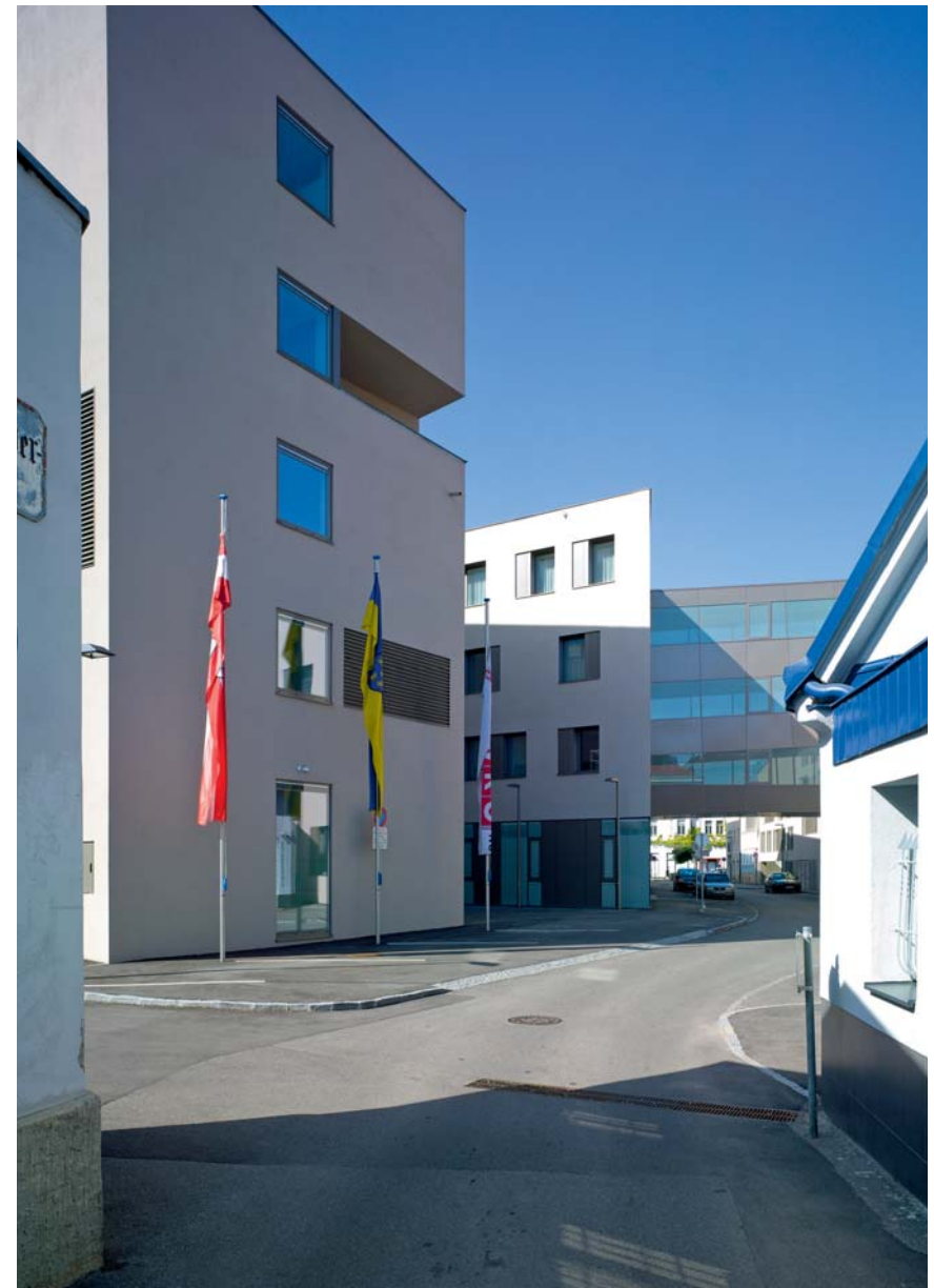
Verkehrsgestaltung Drinkweldergasse, Blickrichtung Westen (Dinstlstraße)
