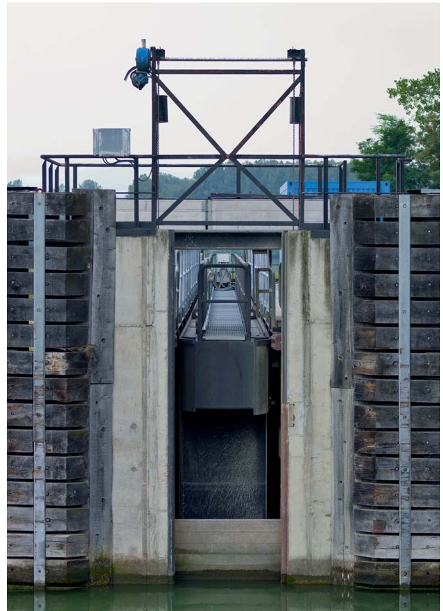
Schiebetor in Torkammer stehend
