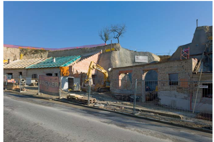
Bauzustand, straßenseitige Kellerhäuser
