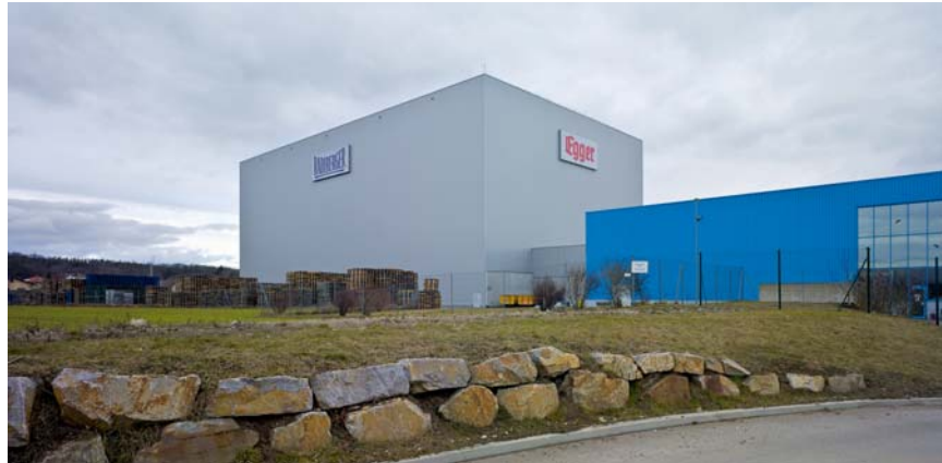
Hochregallager und Lagerhalle
