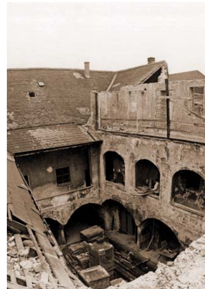
Krems-Stein, Hanikhaus vor der Sanierung
