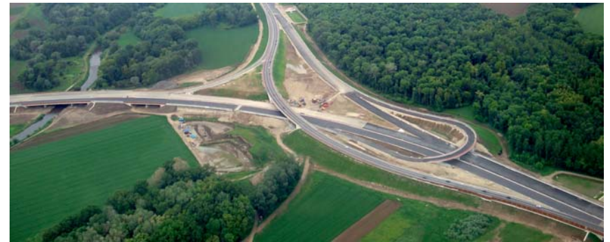
Anschlussstelle Jettzdorf, Bauzustand
