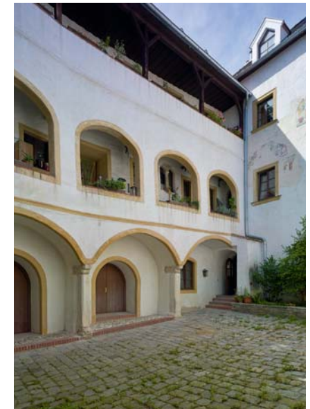
Krems-Stein, Hanikhaus nach der Sanierung
