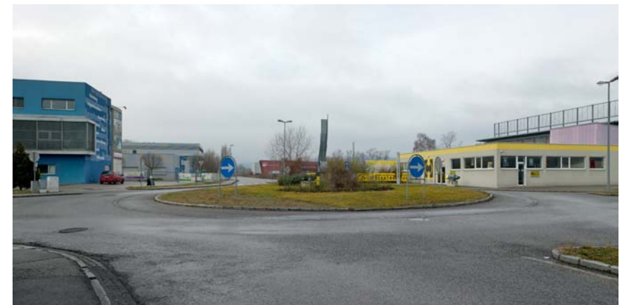
Kreisverkehr Hofrat Erben Straße / Magnesit Straße, Elektro Hoch
