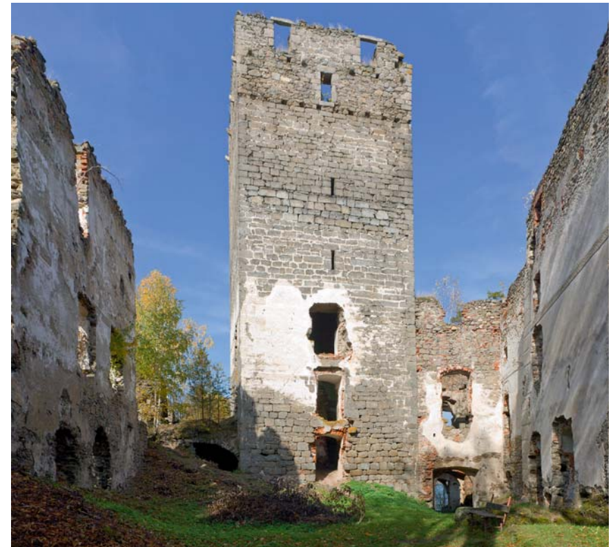
Ansicht Innenhof, Turm
