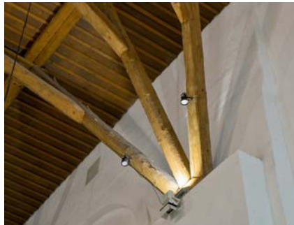
Kirchenschiff, Dachkonstruktion, Detail
