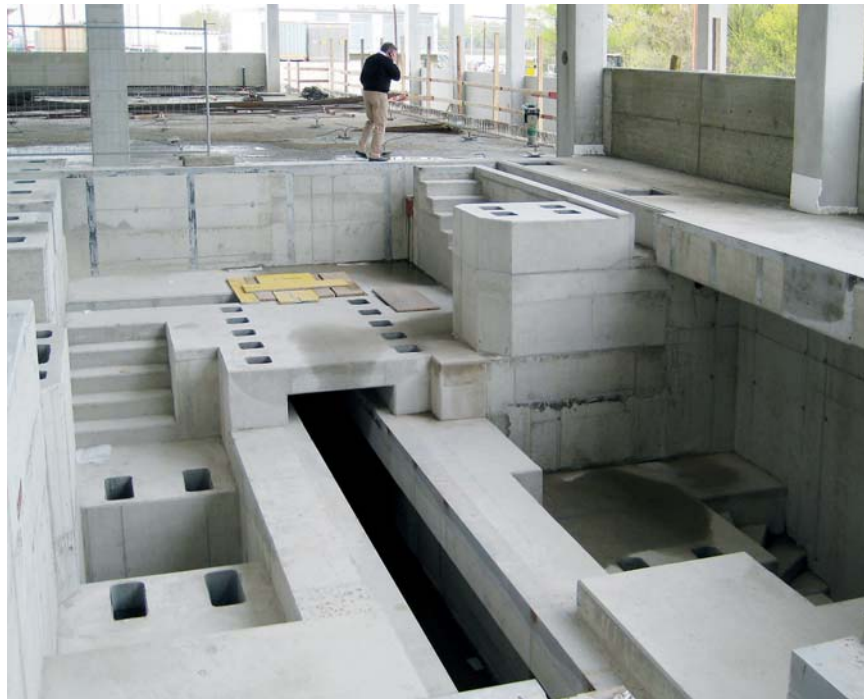
Maschinenfundament
