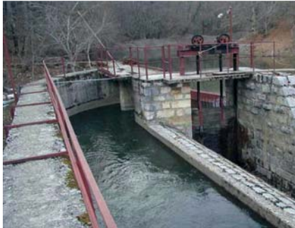
Kraftwerk bei Pesocani (Nr. 4)
