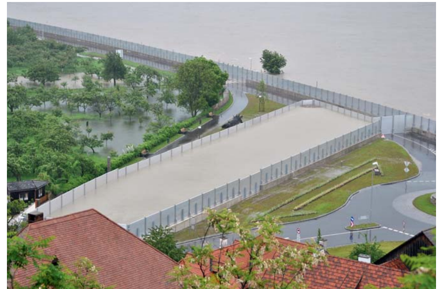
Einmündung Spitzerbach, Hochwasser 2013
