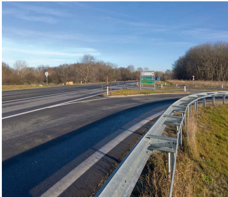
Einmündung in B33 Melker Straße
