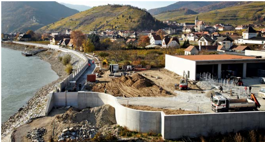
Östlicher Endbereich und Lagerhalle, Bauzustand
