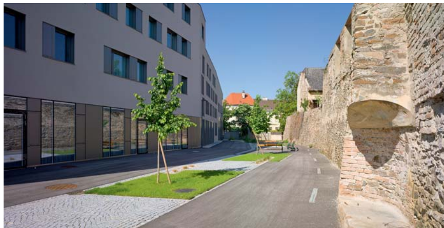
Freigelegte alte Stadtmauer
