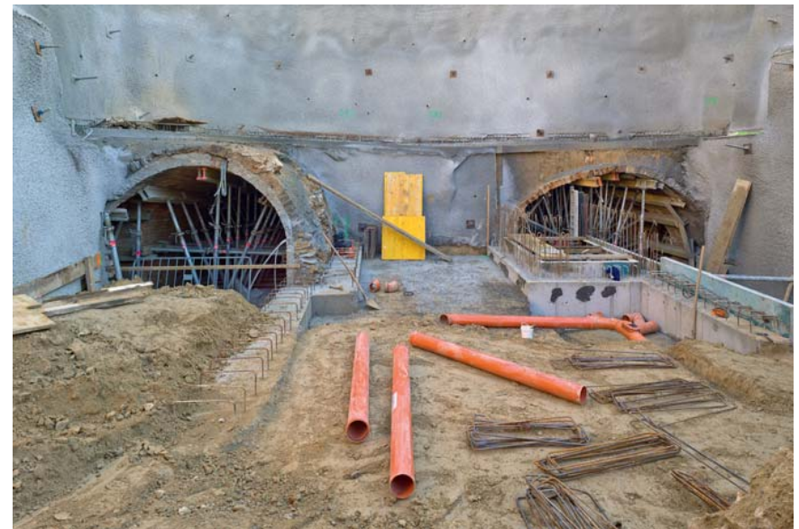
Sicherung der Lösswände
