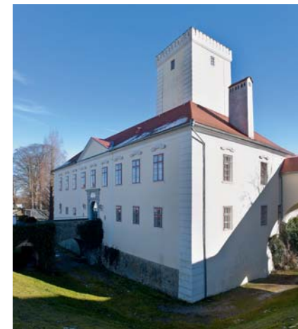
Außenansicht mit Zugangsbrücke
