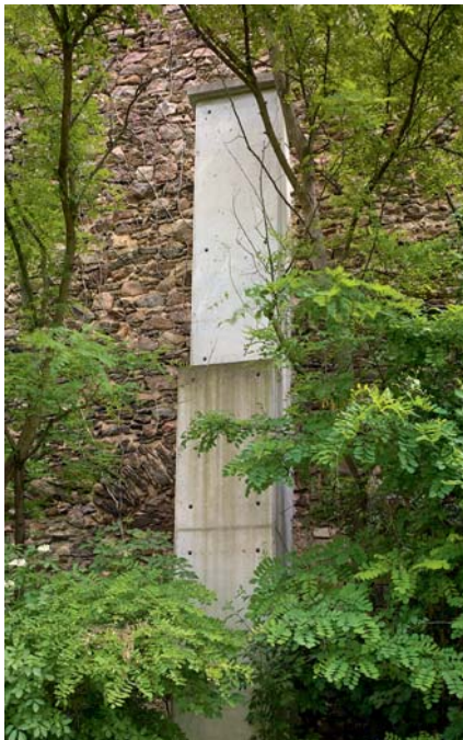
Sicherung südseitige Außenmauer
