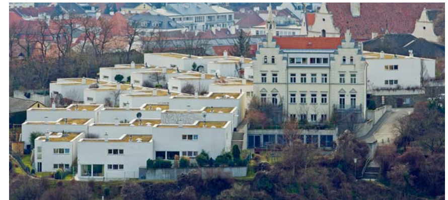
Gesamtansicht von Osten
