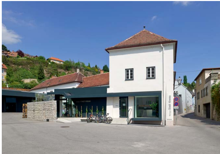
Gesamtansicht von Süden
