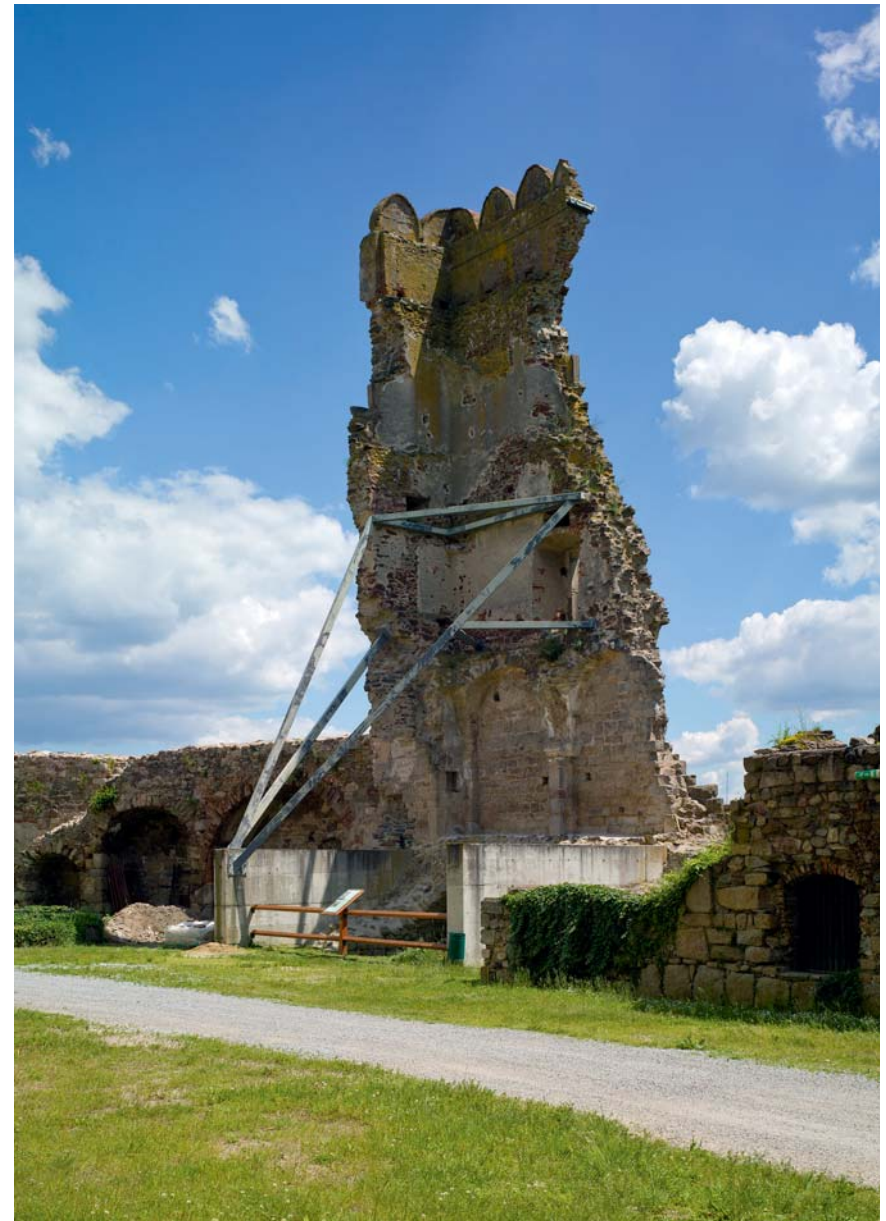
Turmsanierung und -sicherung
