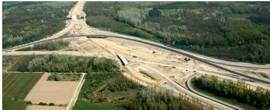
Anschlussstelle Trismauer, Bauzustand
