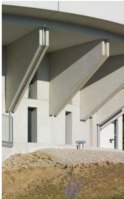
Lastabfangung der Obergeschoße über Konsolen
