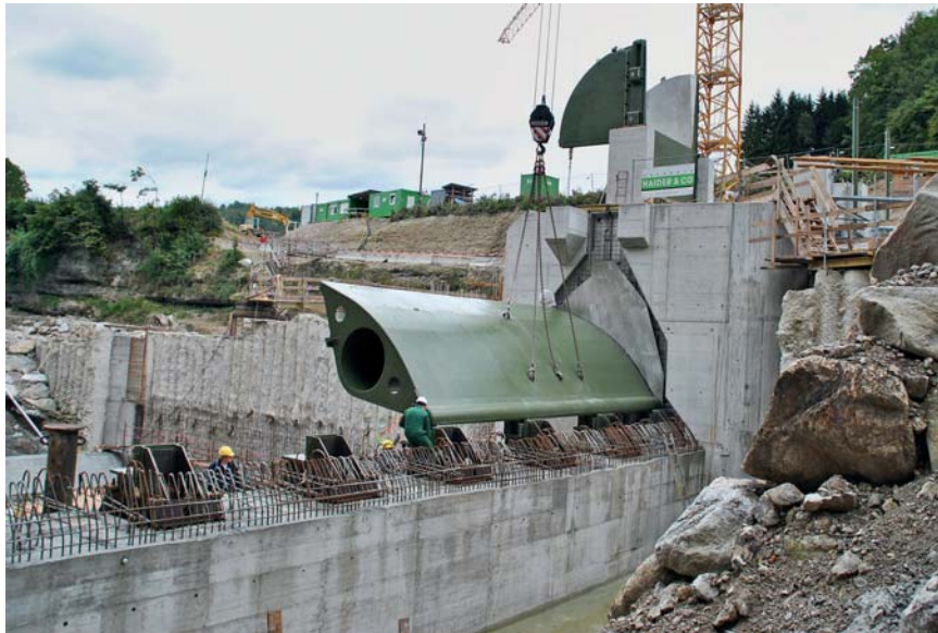
Klappenverschluss, Einbau
