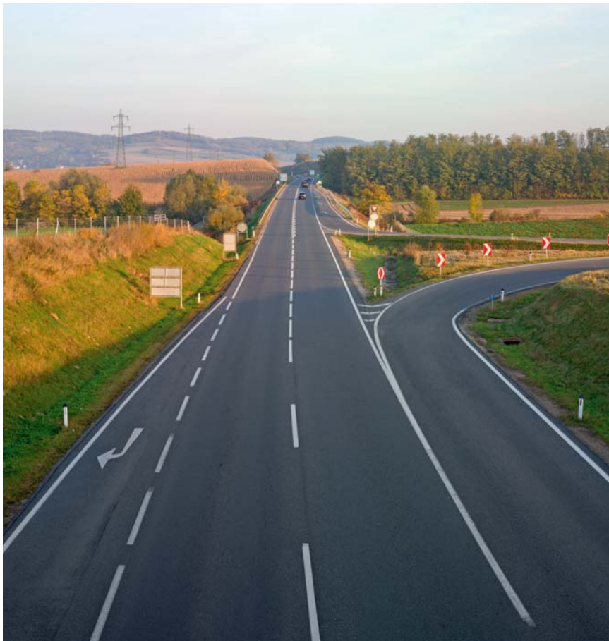
Anschlußstelle Mitte, Teilansicht
