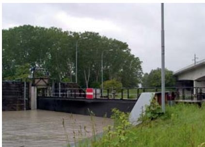
Hochwasser 2013, Schiebetor geschlossen
