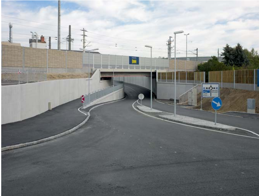
Unterführung Landersdorf Südansicht
