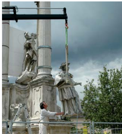
Dreifaltigkeitssäule Krems, Bauzustand
