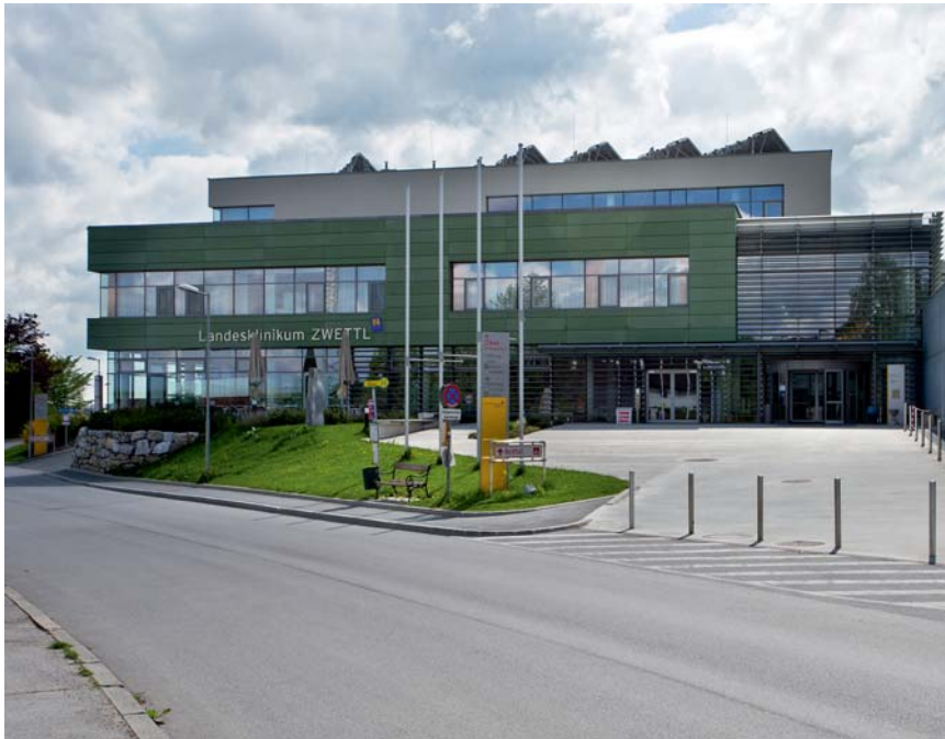
Nordseitige Straßenseite, Landeskrankenhaus Zwettl
