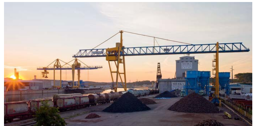
Hafenbecken 1, Schüttgutlagerhalle Süd und Silos
