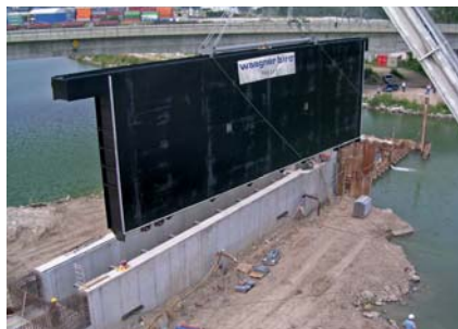
Einheben des Stahlschiebetores
