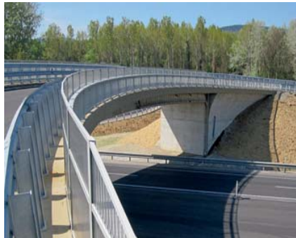
Anschlußstelle Traismauer, Randleistendetail
