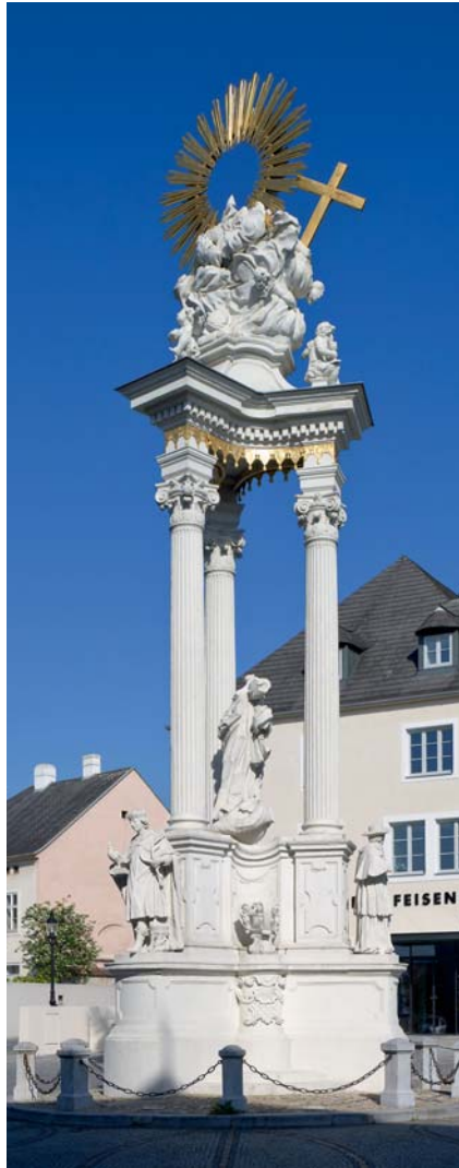
Dreifaltigkeitssäule nach der Sanierung
